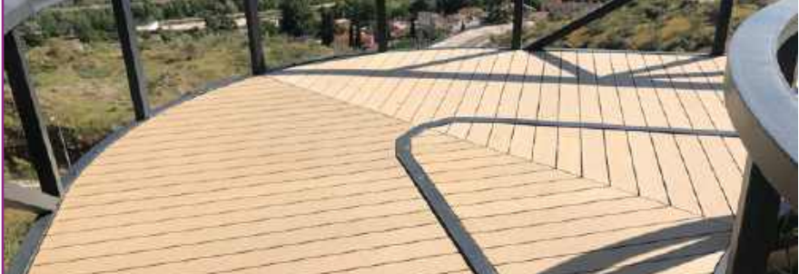
Tarima en pasarelas Decking on catwalks
