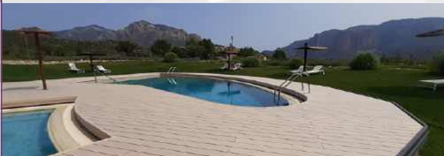
Tarima en piscinas Pool decking
